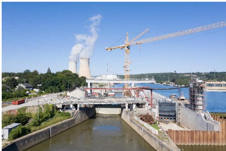
Pour reculer la berge amont dans les terres d'une quinzaine de mètres, la présence d'ouvrages en crête de talus, 8 mètres au-dessus du niveau de la Meuse a nécessité la conception d'un **dispositif de soutènement très spécifique, à l'aide de palplanches, de pieux, de tirants précontraints en acier et de tirants passifs en béton armé**, le tout afin de permettre le garage des bateaux et le passage du RAVeL.
