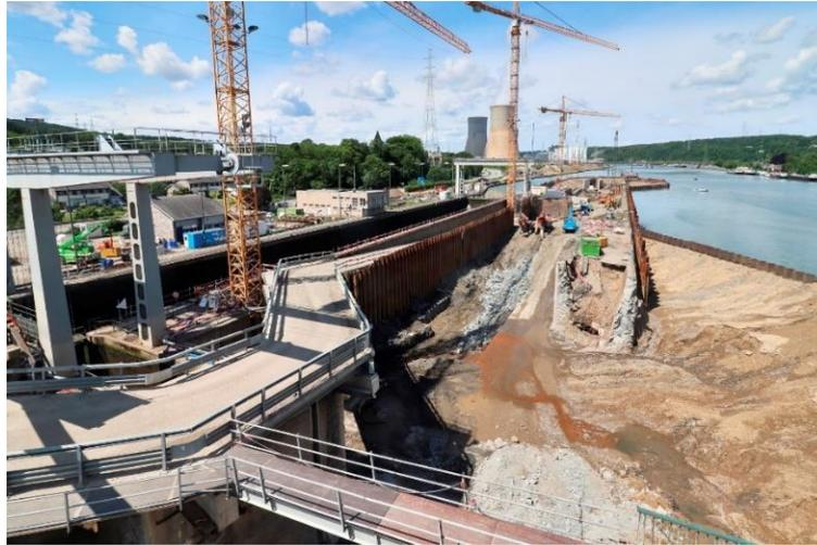
La nouvelle écluse de 4.500 tonnes a dû être construite sur une île entre le fleuve et une écluse maintenue en service. Cette spécificité a nécessité la construction d'un **pont provisoire** permettant l'accès à la zone de chantier.
