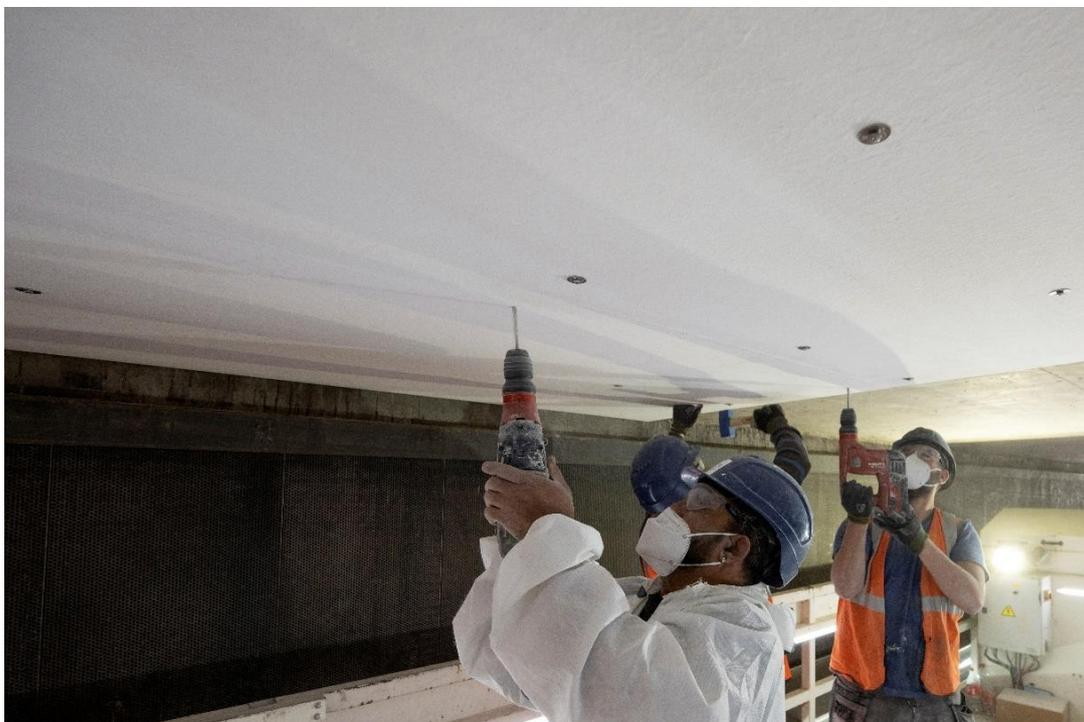
Des analyses de risques menées au sein de la liaison, notamment dans le cadre du Plan Tunnels, ont mis en lumière la nécessité de l'équiper d'une protection passive au feu.
